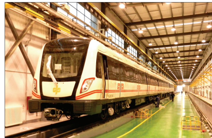
城市轻轨车辆组装及服务基地
