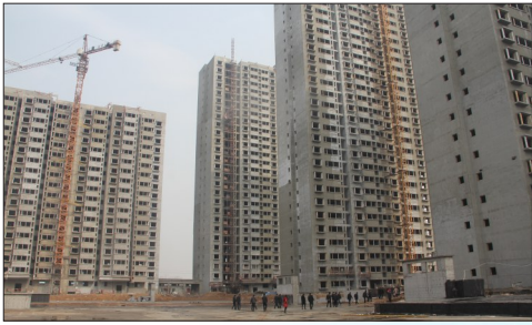
2号安置小区加紧施工
