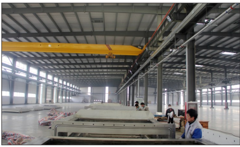
兰迪玻璃生产车间正在进行设备安装
