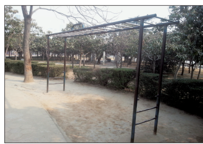
拆除前的天梯已现多处“伤痕”(资料图片)
