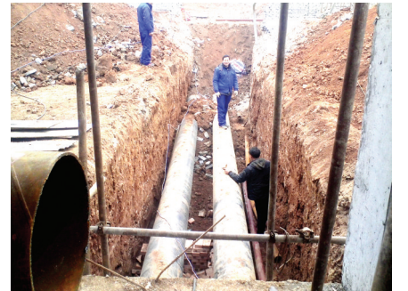
热力管网铺设
