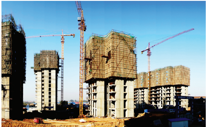
在建的元阳隆城住宅群
