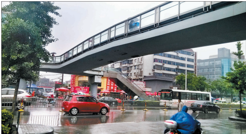
老集过街天桥
