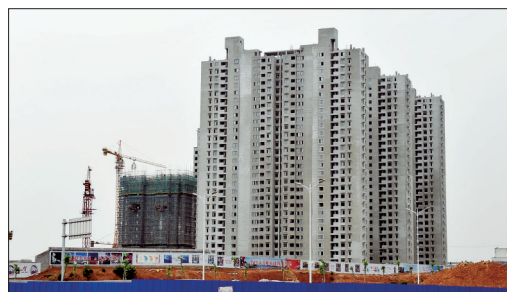
千套公租房即将竣工
