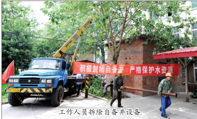
工作人员拆除自备井设备
