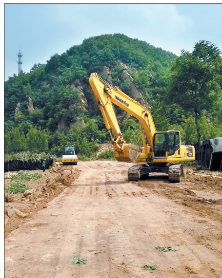
靳泰路拓宽改造工程紧张施工
