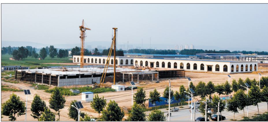
中安LED项目建设工地 黄伟伟 摄
