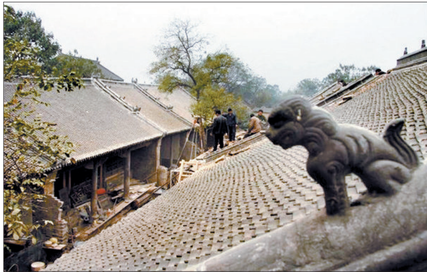
2013年11月,施工人员正在精心修缮卫坡村古民居(资料图片)
