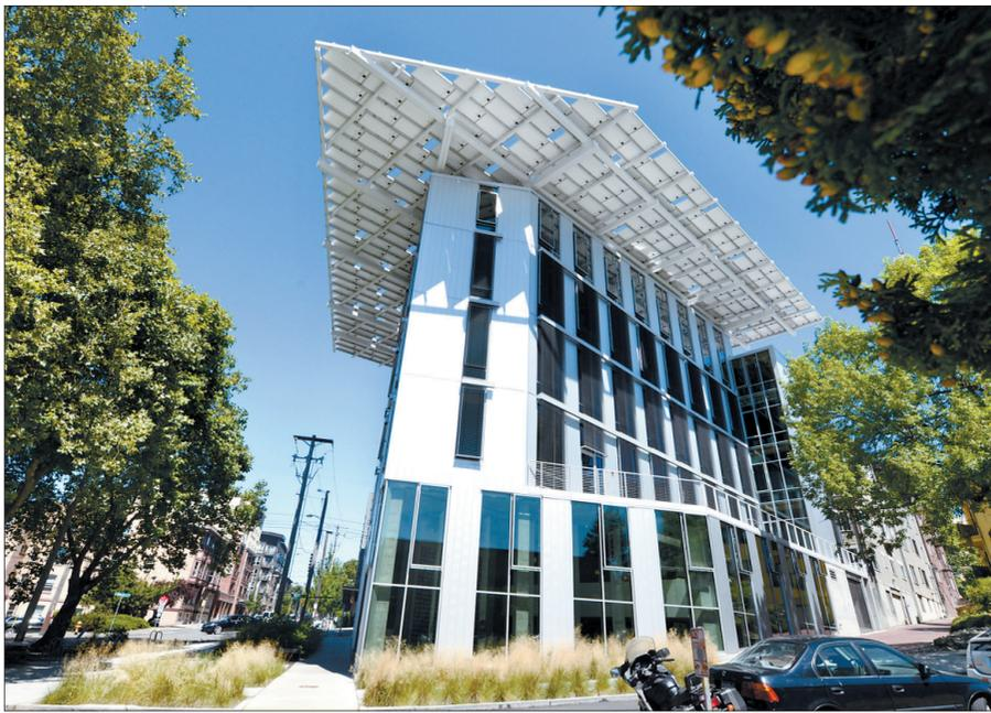
西雅图环保大楼的用电全部来自楼顶的太阳能装置
