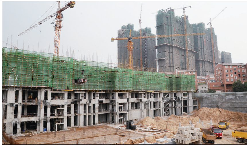
建设中的兴隆寨村改造安置房项目 高德权摄
