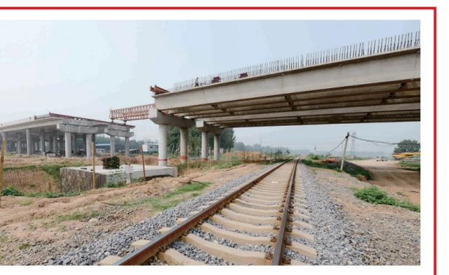
洛栾高速公路洛阳连接线下月通车 昨日,在洛栾高速公路洛阳连接线大桥工程工地上,市政建设集团工人们正加紧进行桥梁吊装和桥面钢筋网铺装施工。该工程北起孙辛路与伊洛路交汇处,南接洛栾高速公路,线路下穿郑西高铁,上跨洛宜铁路,计划9月建成通车。
