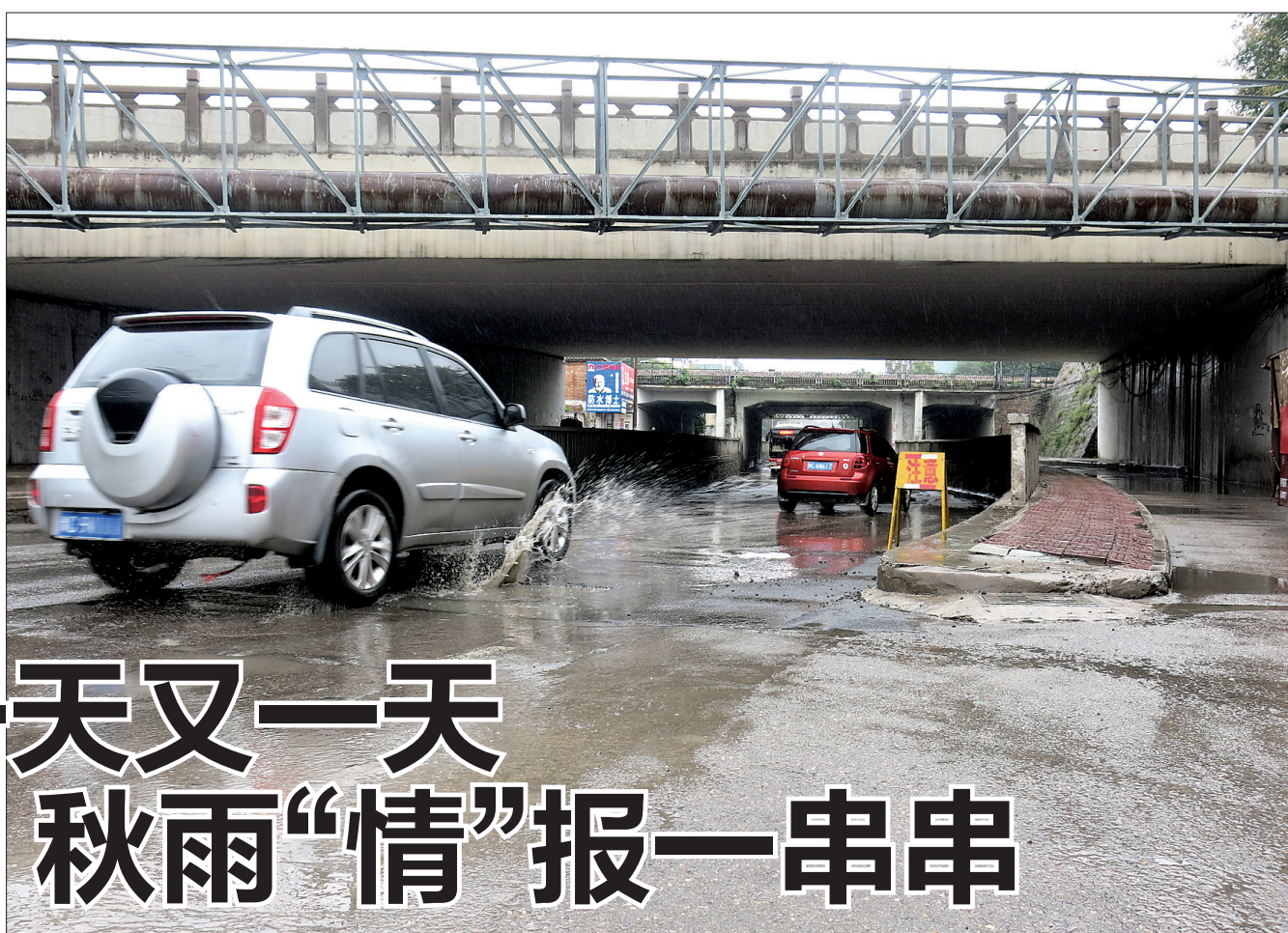
平等街立交桥下未见大面积积水 记者 苏楠 摄
