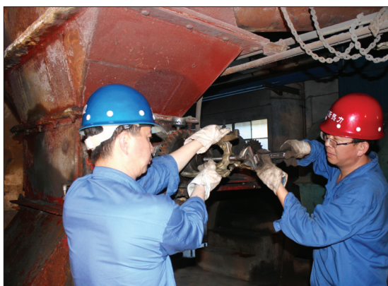
认真检修供热设备
