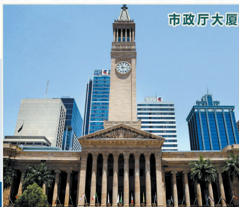
钟楼高106.67米，有瞭望台可俯瞰市容，为布里斯班标志
