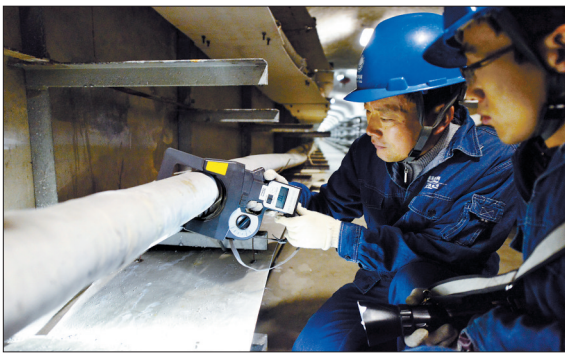
检查电缆电流情况
