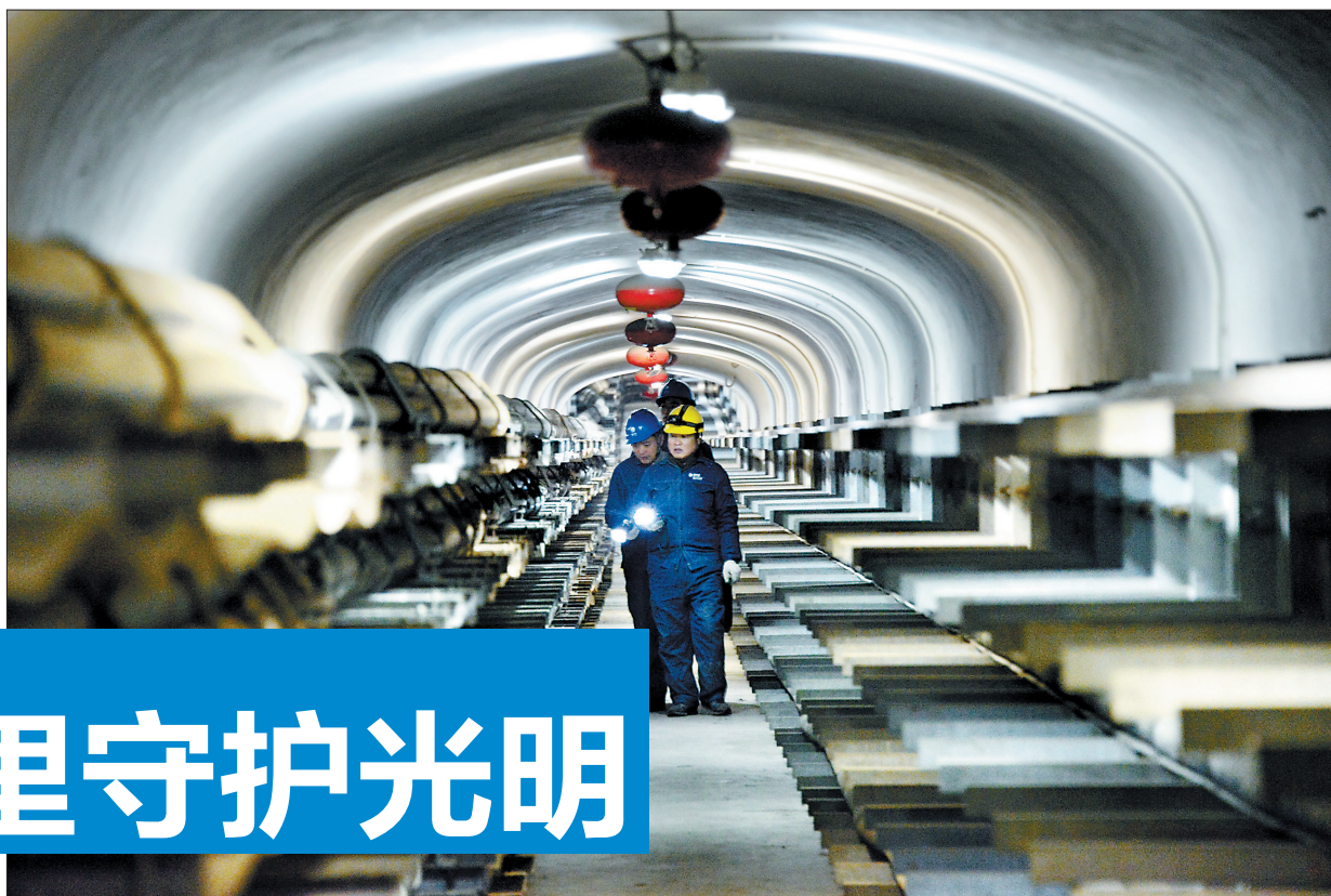
在隧道内巡视
