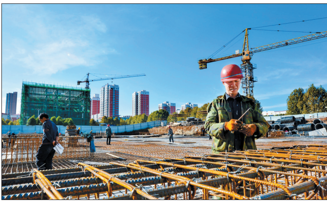
宜阳县图书馆项目正加快建设
