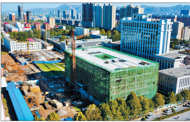
宜阳县文化馆项目主体工程已竣工,进入内部装修阶段
