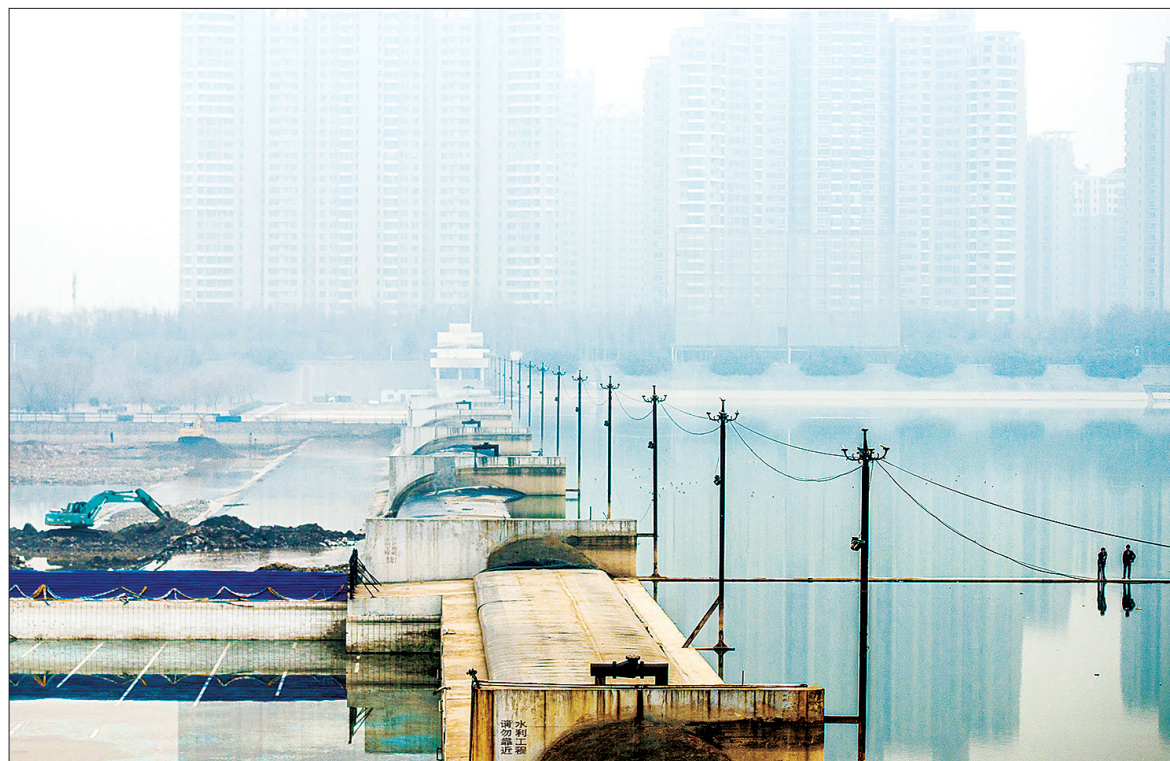
上阳宫橡胶坝修复工程竣工并立坝蓄水
