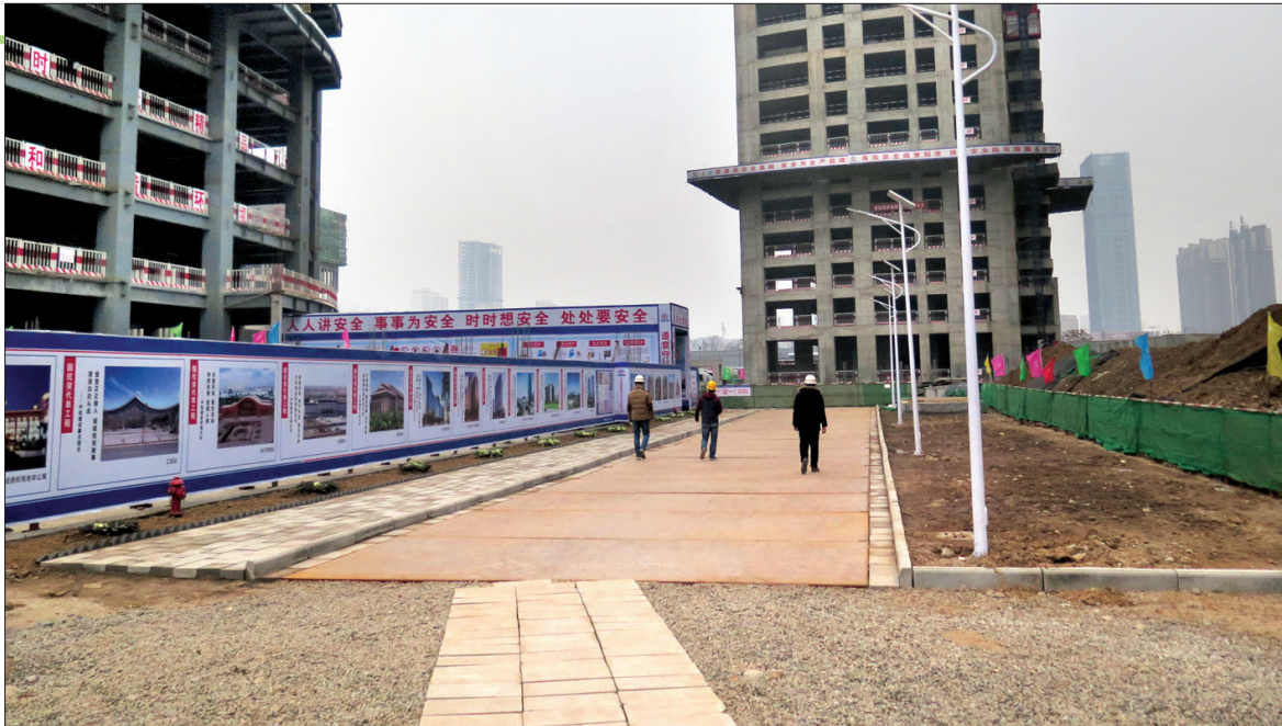
工地里的钢板路
