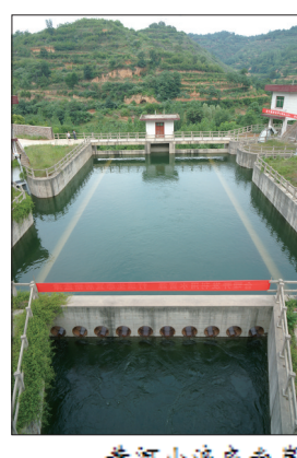
黄河小浪底南岸引水工程分水枢纽
