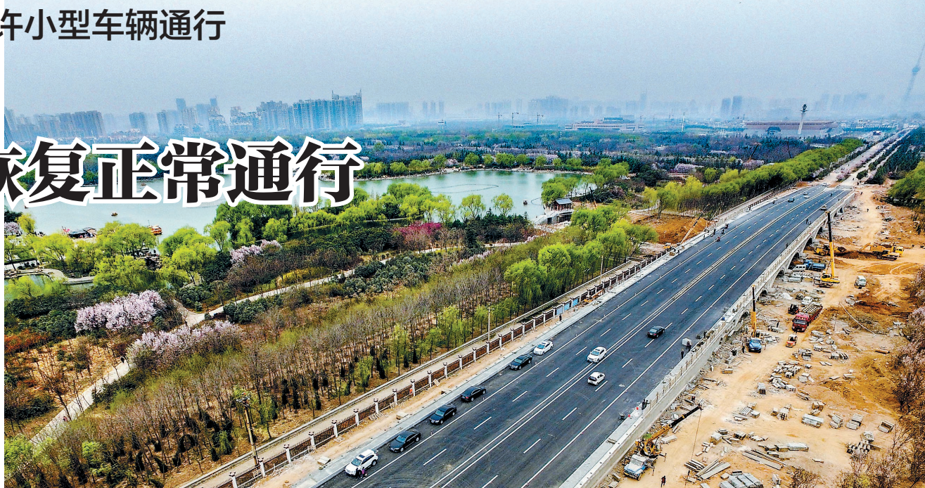
聂泰路九孔桥俯瞰图
