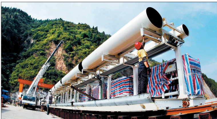
在故县水库引水工程施工现场,TBM正在1号隧洞作业 记者 潘郁摄
