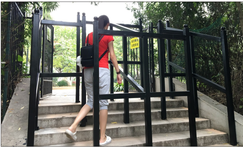
出入口安装有“U”形铁架
