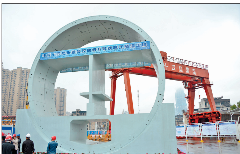
武汉轨道交通8号线一期工程越江隧道项目工地 记者 鲁博 摄
