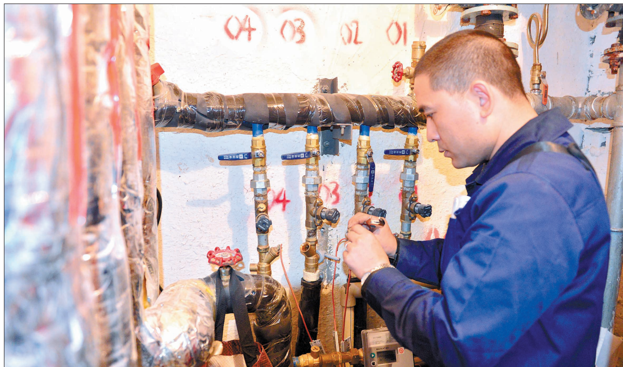
工作人员在清洗用户管道过滤器,保证用户供热管道畅通 记者 李卫超 摄
