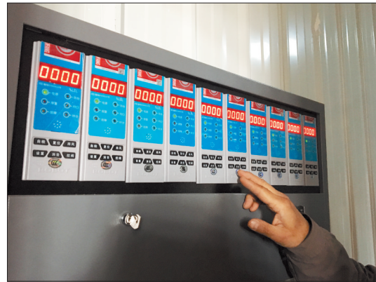
▲分布式燃气供热的燃气泄漏监测报警系统
