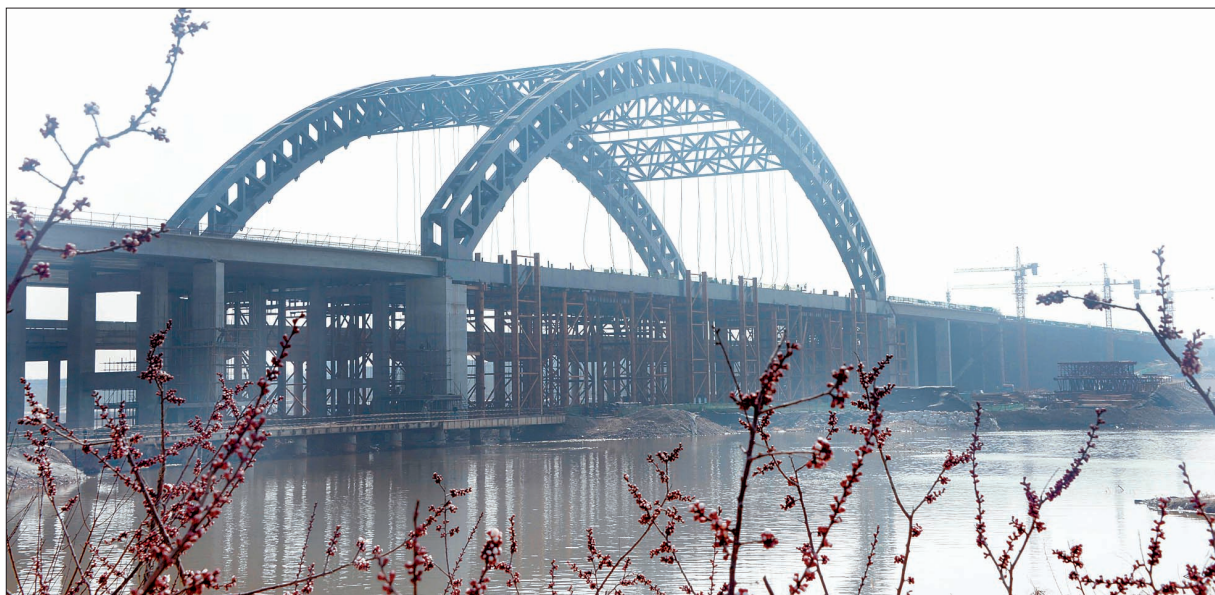
建设中的东环路跨洛河桥 记者 梅占国 摄
