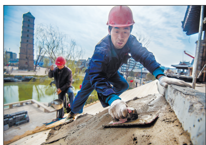
工人正在进行外立面装修
