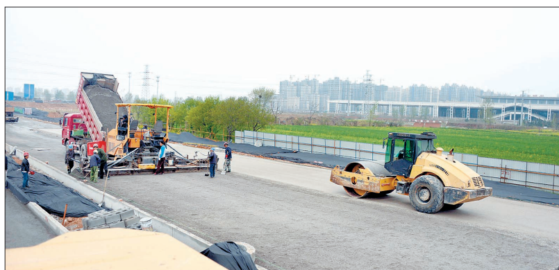
建筑垃圾经处理后用于南环路路基铺设 记者梅占国摄
