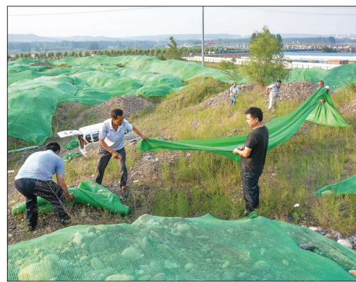
对露天堆放的建筑材料进行遮盖
