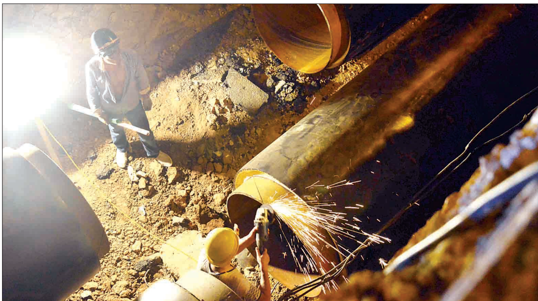
日前,在位于涧西区建设路的集中供热工程现场,施工人员正在进行焊接作业 记者 潘郁 摄
