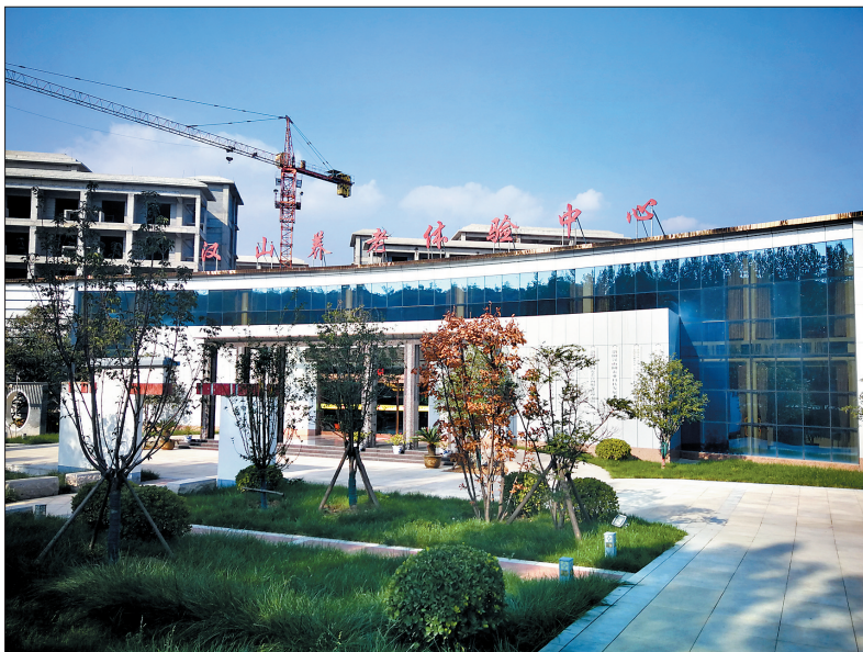
建设中的中国汉山(洛阳)老年康养基地
