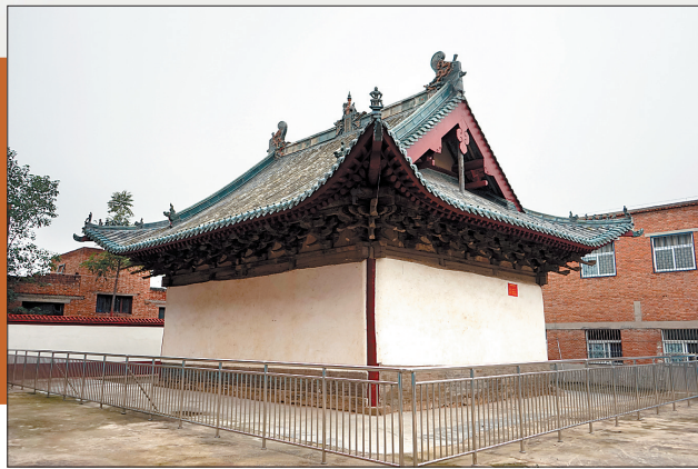
修缮后的兴福寺大殿
