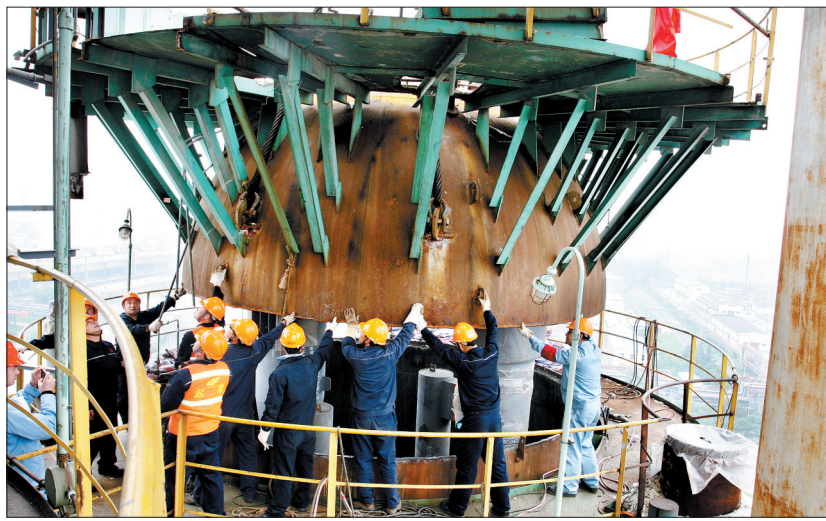
技术人员对核心设备2号催化裂化装置进行改造
