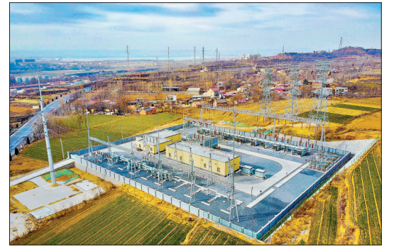
新建输变电工程 保障炼油结构调整项目
