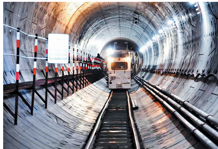
初具规模的盾构隧洞
