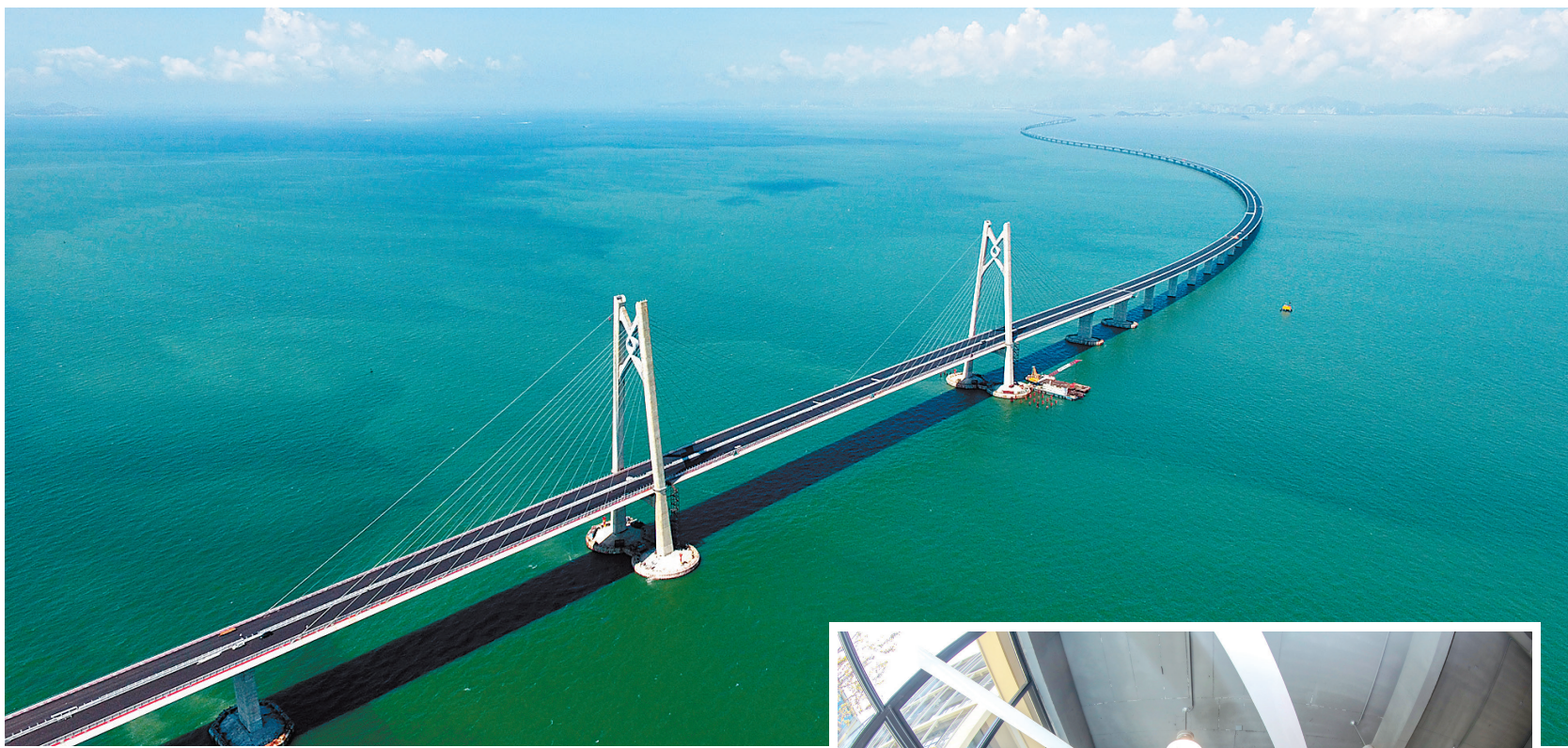
158个“洛阳支座”撑起港珠澳大桥 (新华社发)
