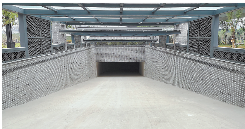
隋唐园立交地下停车场出入口
