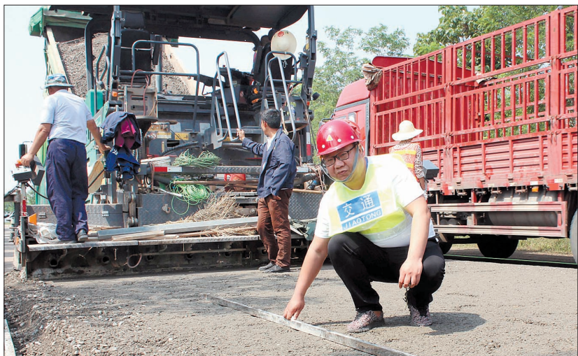
游立波在公路建设工地
