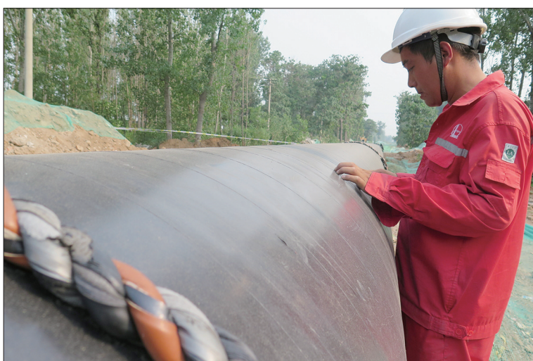
“日照—濮阳—洛阳”原油管道工程建设现场,工人正在检查管道
