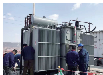
大型过载变压器安装
