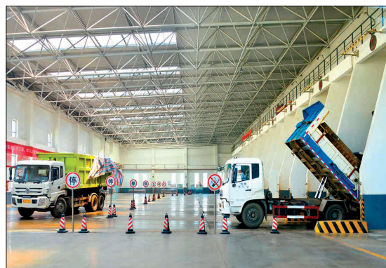
洁净的垃圾处理车间
