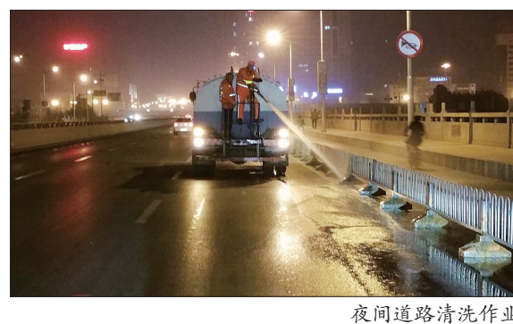
夜间道路清洗作业
