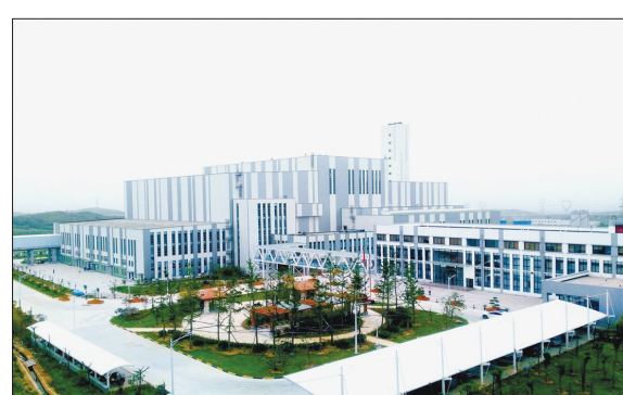
日处理生活垃圾1500吨发电厂
