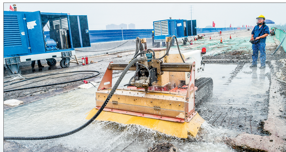
中信重工自主研发制造的超高压水射流机器人首次参与“实战”
