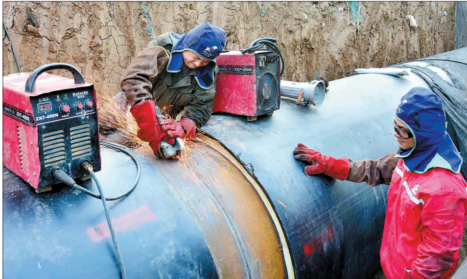
在高新区河洛路热力管道施工现场,建设者正对直径1200毫米的热力管道进行焊接作业。 记者 潘郁 摄
