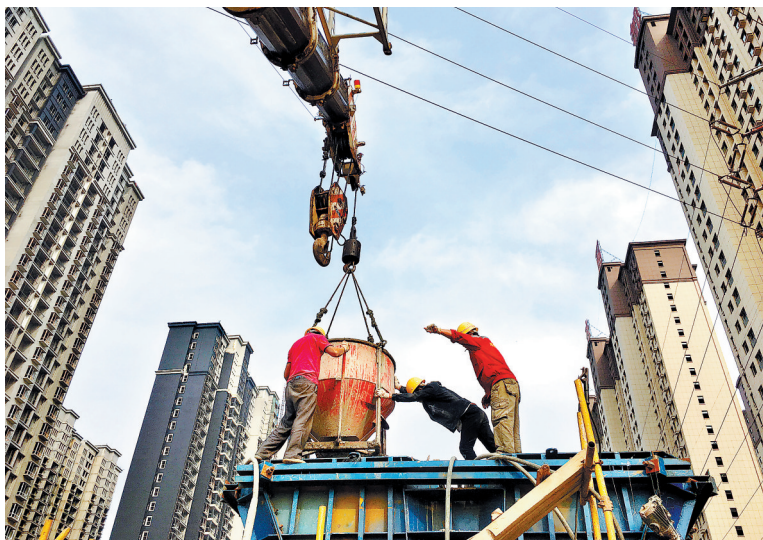
国庆假期,在王城大道快速路一期工程施工现场,工人加紧桥墩施工。记者梅占国 通讯员毕亚杰 摄
