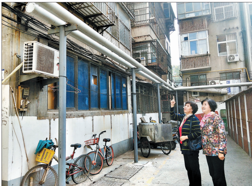
居民看着安装完毕的供热管道满心欢喜
