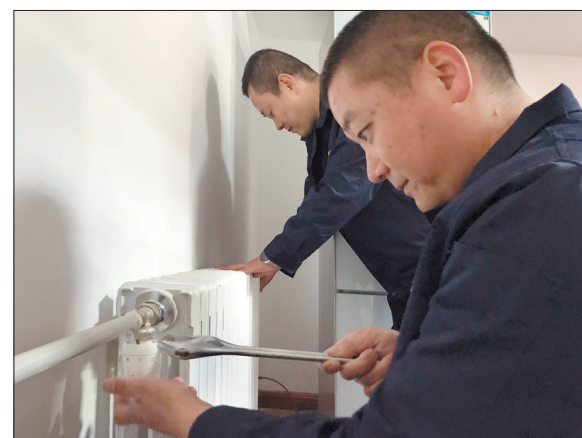
热力工人在老旧小区开阀、维修
