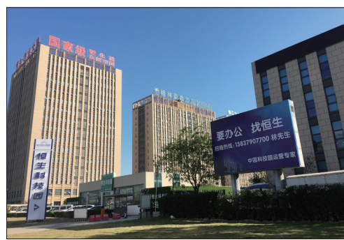
洛阳恒生科技园
