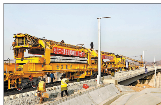
崇礼铁路开始全面铺轨
